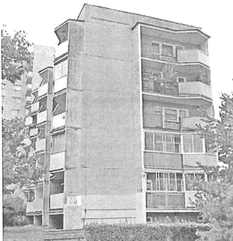
Fot. 7. Kraków, ul. Grota-Roweckiego 25, elewacja południowa i wschodnia.
