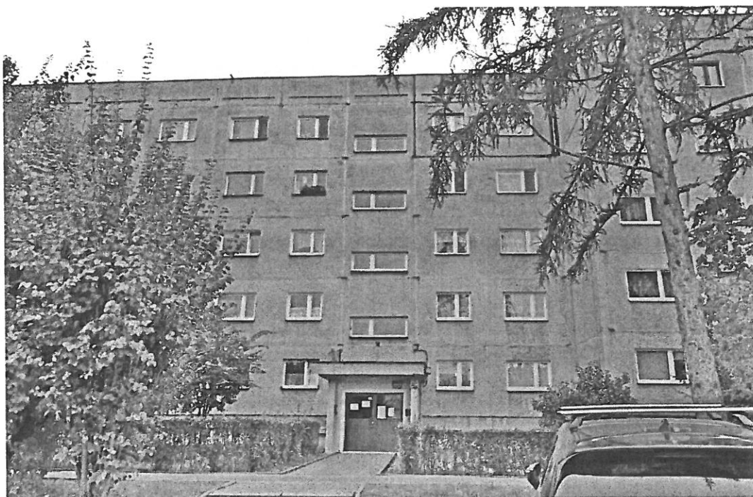
Fot. 3. Kraków, ul. Grota-Roweckiego 25, segment pierwszy, elewacja północna.
