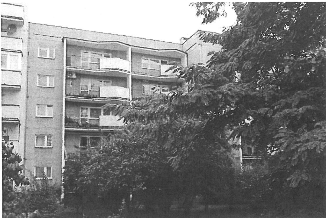
Fot. 6. Kraków, ul. Grota-Roweckiego 25, segment drugi, elewacja południowa.
