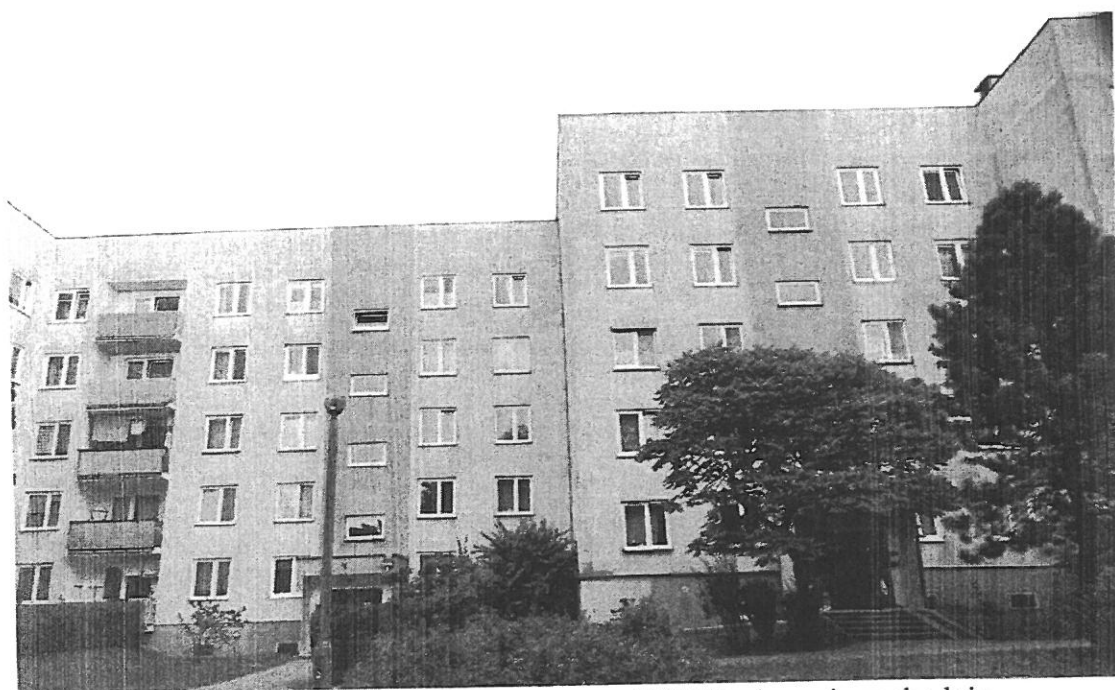
Fot. 5. Kraków, ul. Kobierzyńska 101, segment III i IV, elewacja zachodnia.
