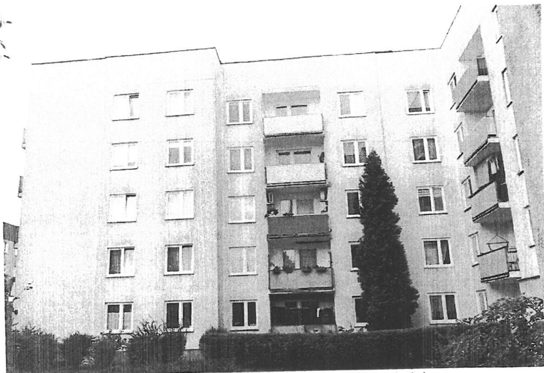
Fot. 4. Kraków, ul. Kobierzyńska 101, segment I, elewacja południowa.
