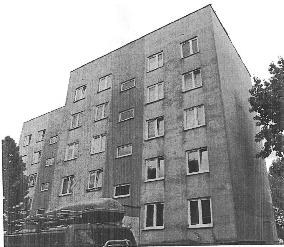
Fot. 7. Kraków, ul. Kobierzyńska 101, segment IV i V, elewacja zachodnia i południowa.
