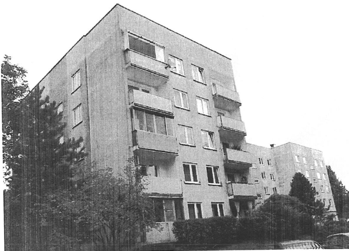
Fot. 3. Kraków, ul. Kobierzyńska 101, segment I, elewacja północna i zachodnia.
